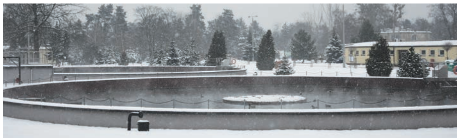
// Oczyszczalnia ścieków na terenie OPWiK
