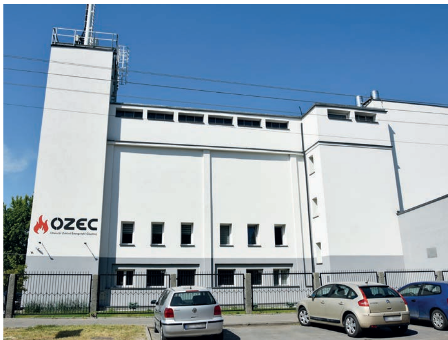
// Siedziba Otwockiego Zakładu Energetyki Ciepłej przy ul. Andriollego 64
