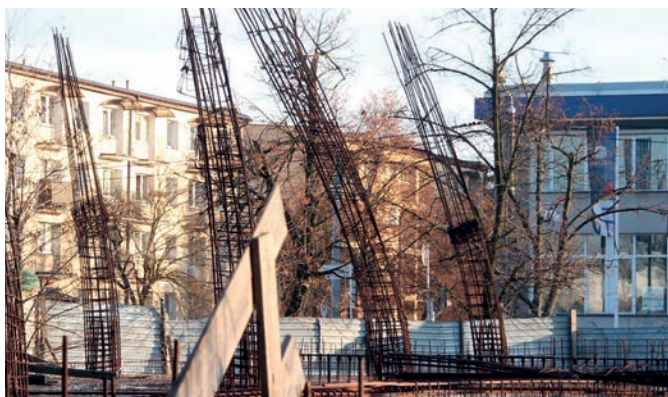
// „Wielka dziura” szpeciła centrum Otwocka przez prawie 17 lat
