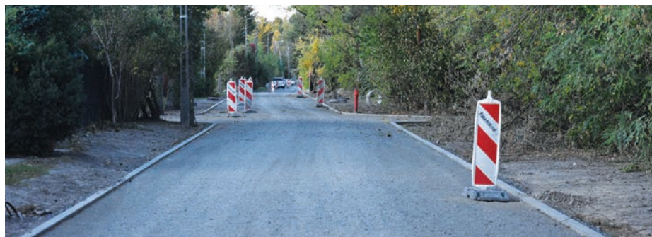
// Ulica Wiejska w trakcie budowy
