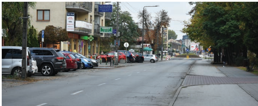
// Odcinek ul. Andriollego do remontu
