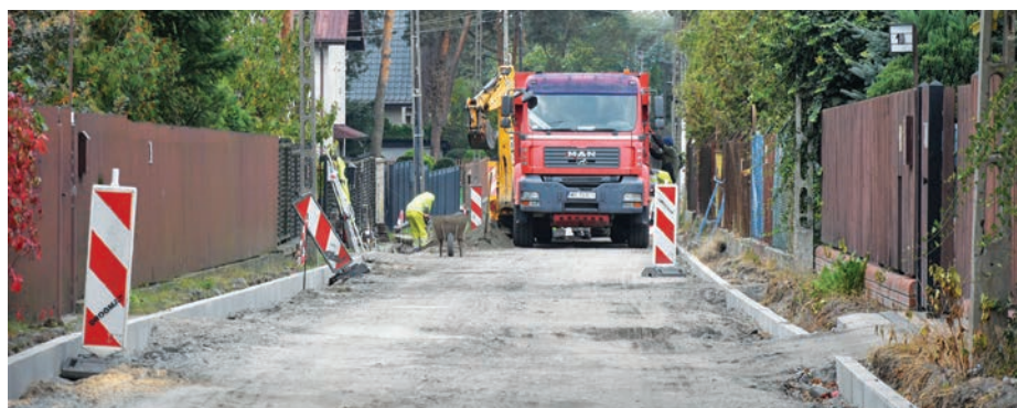
// Budowa ul. Kwiatowej
