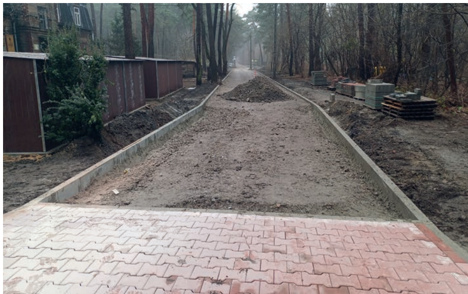
// Ulica Świerkowa w trakcie budowy
