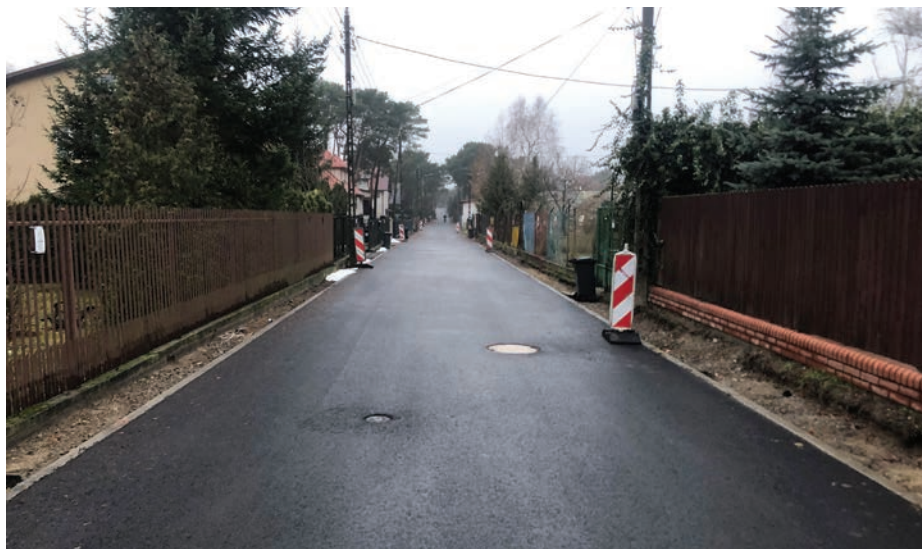
// Ulica Kwiatowa już z nawierzchnią asfaltową
