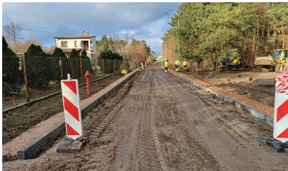
// Budowa nawierzchni asfaltowej na ul. Ługi za targowiskiem miejskim
