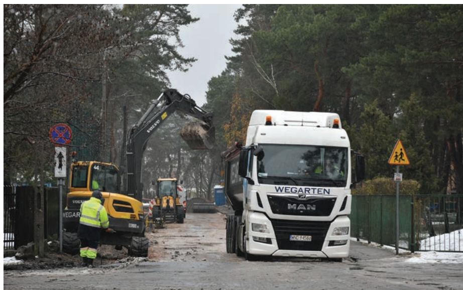
// Modernizacja ul. Dwernickiego przy przedszkolu nr 4
