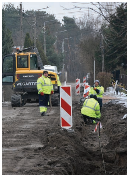
// Prace na ul. Mazurskiej
